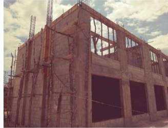
Foto No. 7: Formaleta solera corona, segundo nivel, Módulo Uno.
