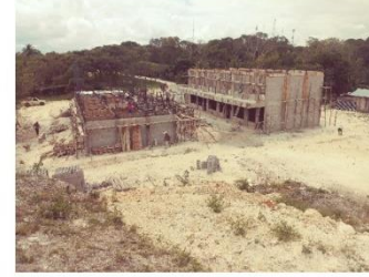
Foto No. 8: Vista general de la obra al 13 marzo 2018
