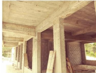
Foto No. 2: Desencofrado de vigas en voladizo, Módulo Uno.
