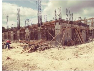
Foto No. 3: Armado vigas perimetrales entrepiso, Módulo Dos.
