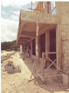
Foto No. 5: Vista general del voladizo entrepiso, Módulo Uno.
