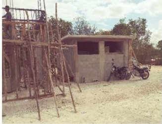
Foto No. 6: Módulo Servicios Sanitarios, sin formaleta
