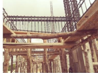
Foto No. 4: Armado de vigas principales en entrepiso, Módulo Dos.
